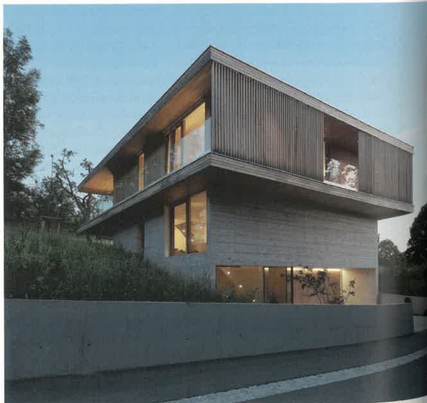
Das Haus ist ein Hybridgebäude: Zwei Geschosse aus Sichtbeton tragen das darüber auskragende Wohngeschoss aus Holz.
