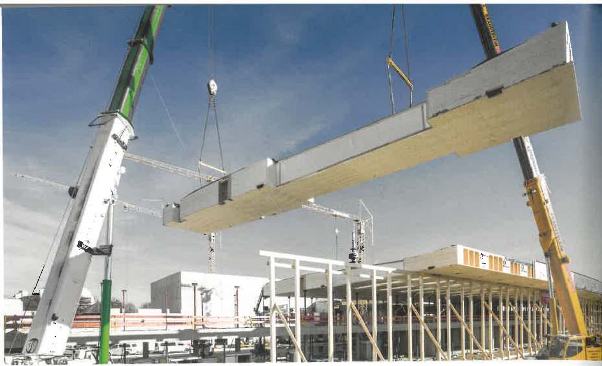
Das 19 m auskragende Dach besteht aus vorgefertigten Hohlkastenelementen mit hoher Steifigkeit bei geringem Gewicht.
