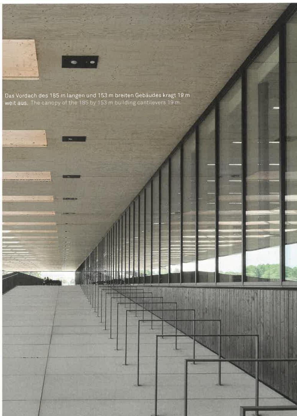
Das Vordach des 185 m langen und 153 m breiten Gebäudes kragt 19 m weit aus. The canopy of the 185 by 153 m building cantilevers 19 m.
