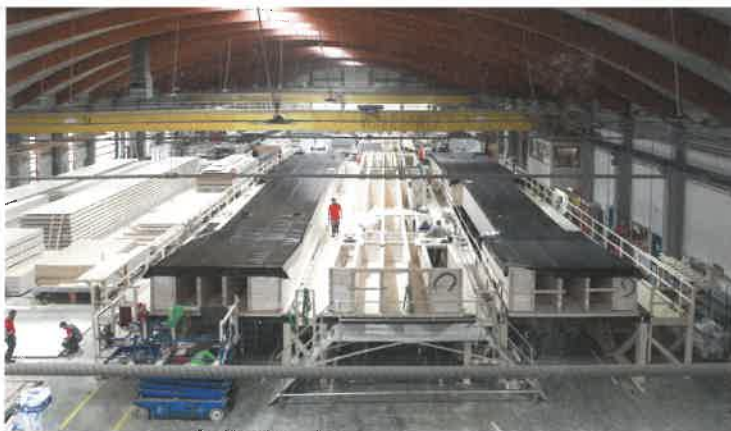
Foto: Rubner Holzbau
