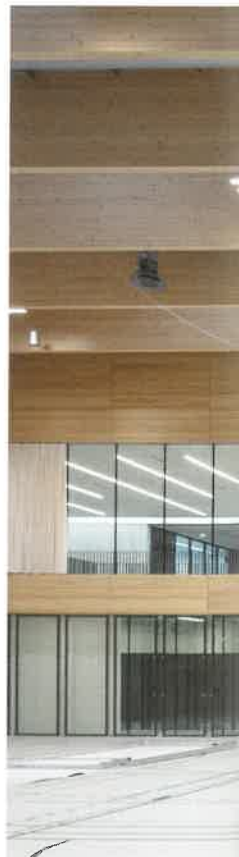
Die Sporthallen sowie die Rue Interieure überspannen konventionelle Brettschichtholzkonstruktionen
