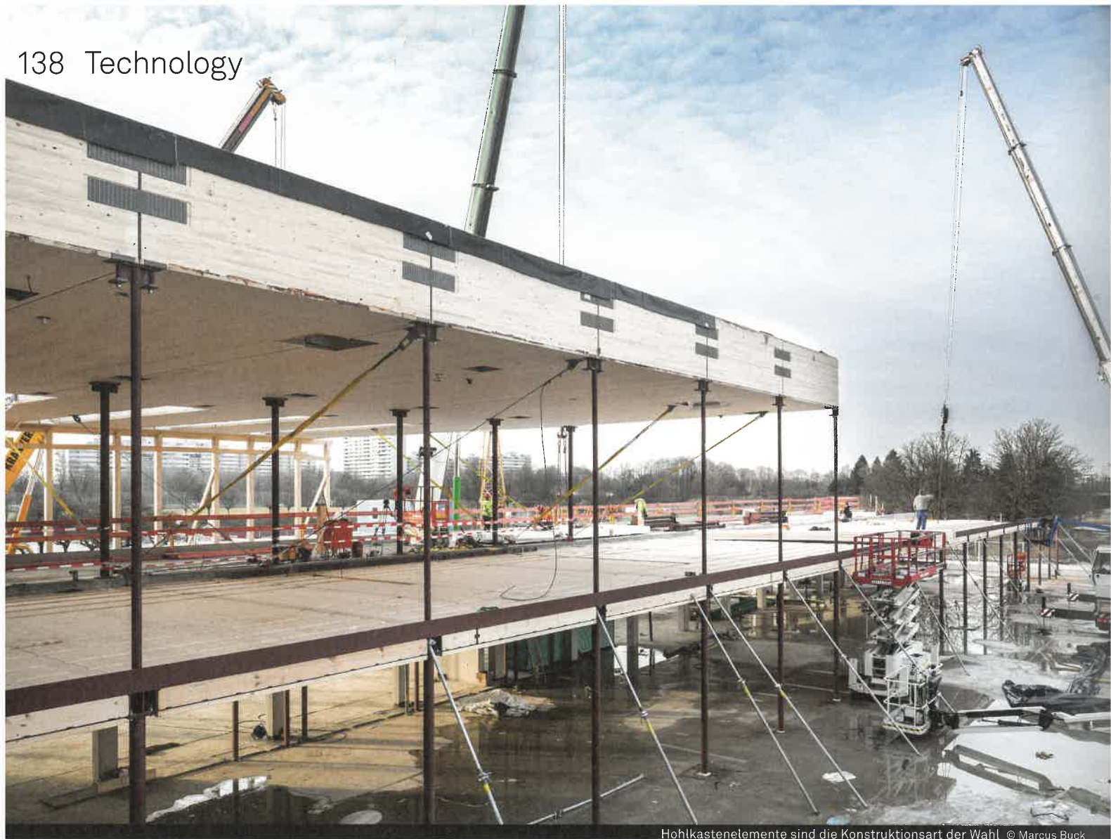
Hohlkastenelemente sind die Konstruktionsart der Wahl © Marcus Buck
