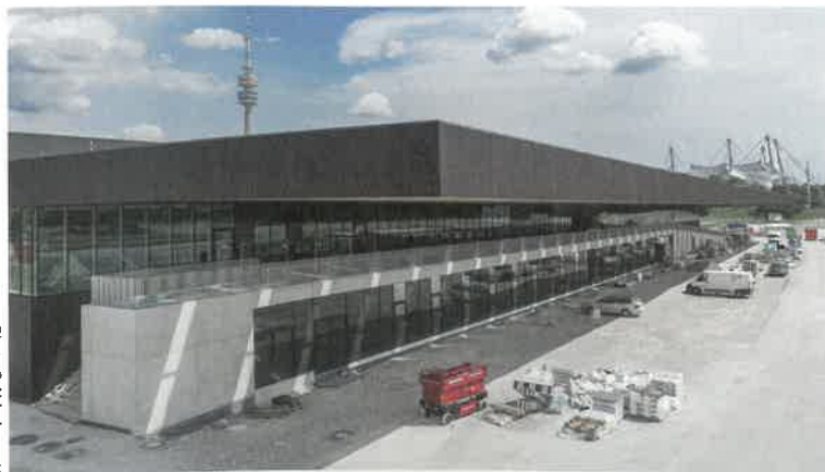
Vor dem Hallenkomplex entsteht so ...
