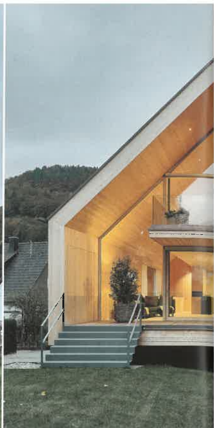
Die Verglasung bis unter den Giebel wird von der auskragenden Galerie durchbrochen.
