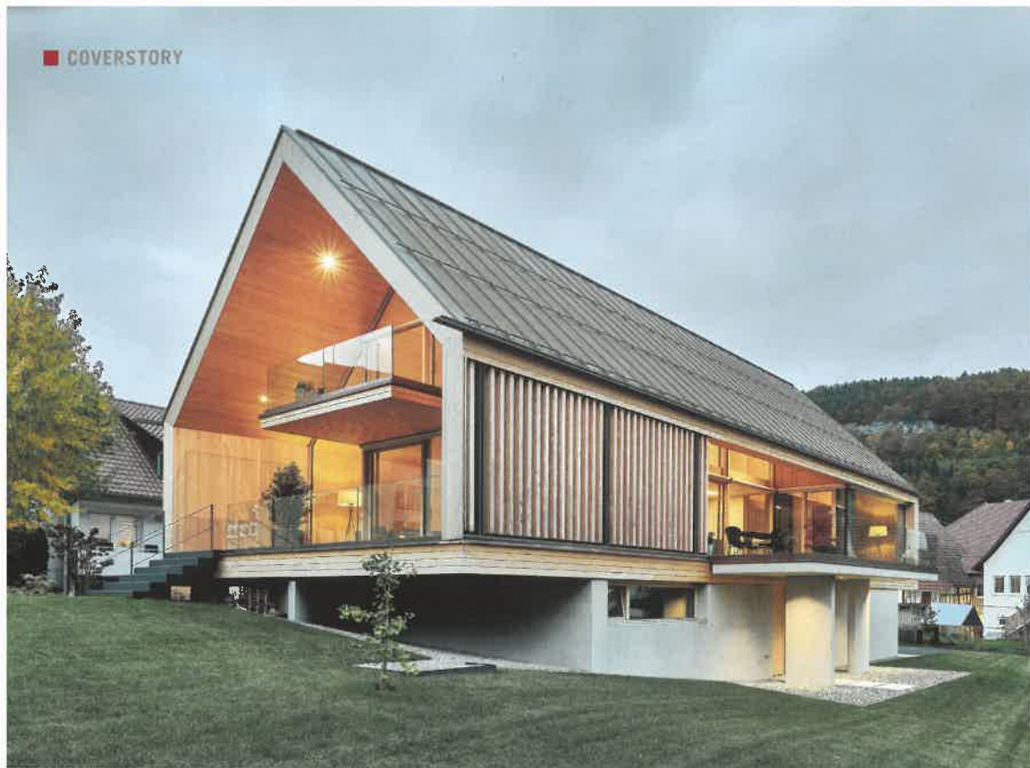
Ein besonderes Detail sind für die Planer die Stahlprofile, die zwischen den Holzlamellen ganz bewusst sichtbar belassen wurden.
