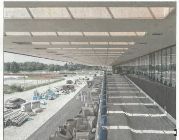
Die großzügig bemessenen Oberlichter bringen viel Tageslicht unters Dach und lassen es optisch leichter erscheinen. Foto: Aldo Amoretti
