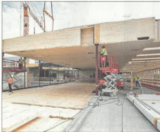
Jedes der 3,75 m breiten Hohlkasten-Elemente des Vordachs ruht auf vier filigranen Stahlstützen – zwei davon in Form von Pendelstützen in der Ebene der Glasfassade unter dem blockverklebten BSH-Querträger und zwei am hinteren Ende in der Gebäudeachse. Fotos: Rubner Holzbau (links), Merz Kley Partner (rechts)
