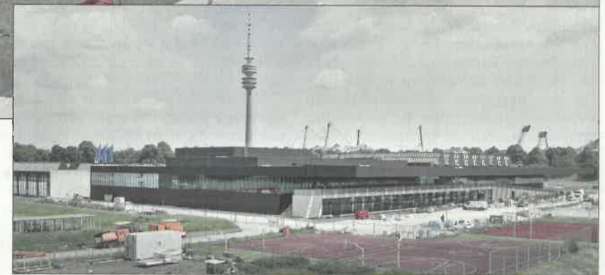
Prägend für die Bauaufgabe war das weit auskragende Vordach aus 40 Hohlkasten-Elementen. Die knapp 28 m langen und 1,60 m hohen Dachelemente haben eine freie Auskragung von 18,60 m und schützen später die 100-Meter-Laufbahn vor der Terrasse bzw. Rampe auf einer Länge von 150 m. Fotos: Aldo Amoretti (2)
