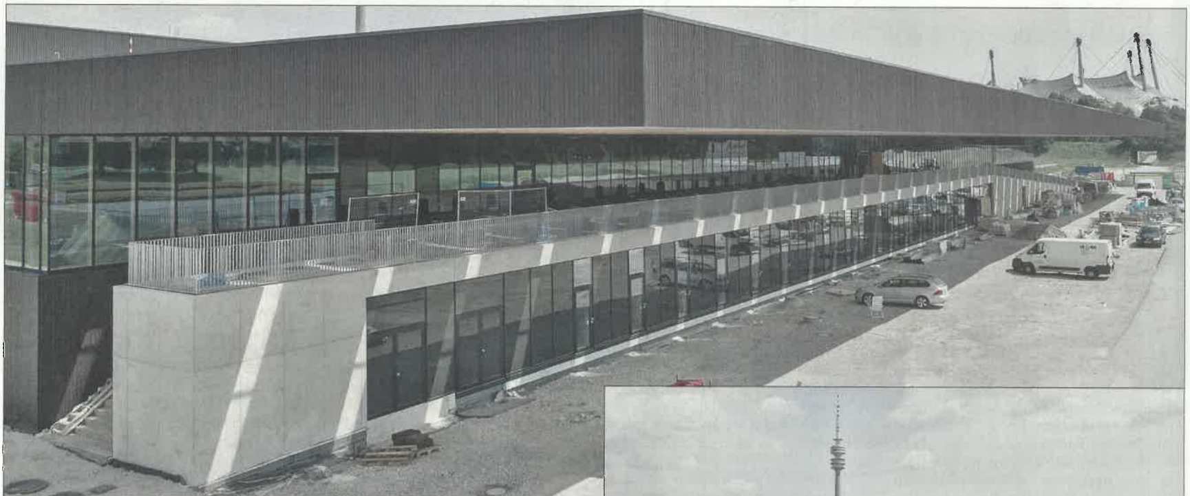
Prägend für die Bauaufgabe war das weit auskragende Vordach aus 40 Hohlkasten-Elementen. Die knapp 28 m langen und 1,60 m hohen Dachelemente haben eine freie Auskragung von 18,60 m und schützen später die 100-Meter-Laufbahn vor der Terrasse bzw. Rampe auf einer Länge von 150 m. Fotos: Aldo Amoretti (2)
