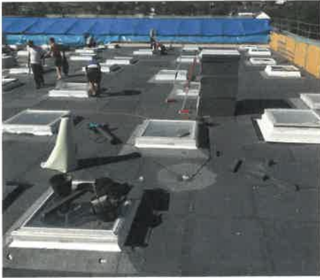
Die Oberlichter sind montiert, ein Teil der Dämmung ist aufgebracht und an die Aufsatzkränze angeschlossen Fotos (2): Spenglerei Heinzle
