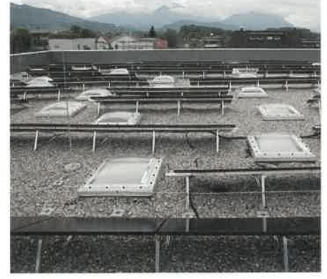
Blick auf das fertige Dach der Sporthalle. Das Dach ist auch mit einer PV-Anlage versehen Foto: Velux / Patricia Weisskirchner
