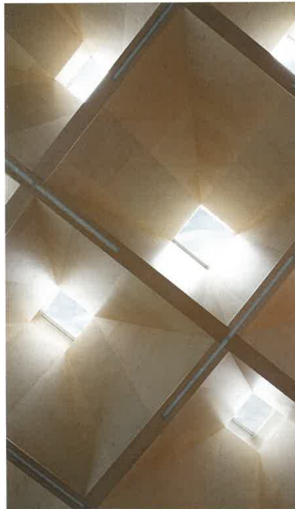
Spezielle Lichteffekte: Über die in der Neigung bewusst unterschiedlich ausgeführten, pyramidenförmigen Laibungen wird das Tageslicht in die Halle geführt Foto: Velux / Patricia Weisskirchner
