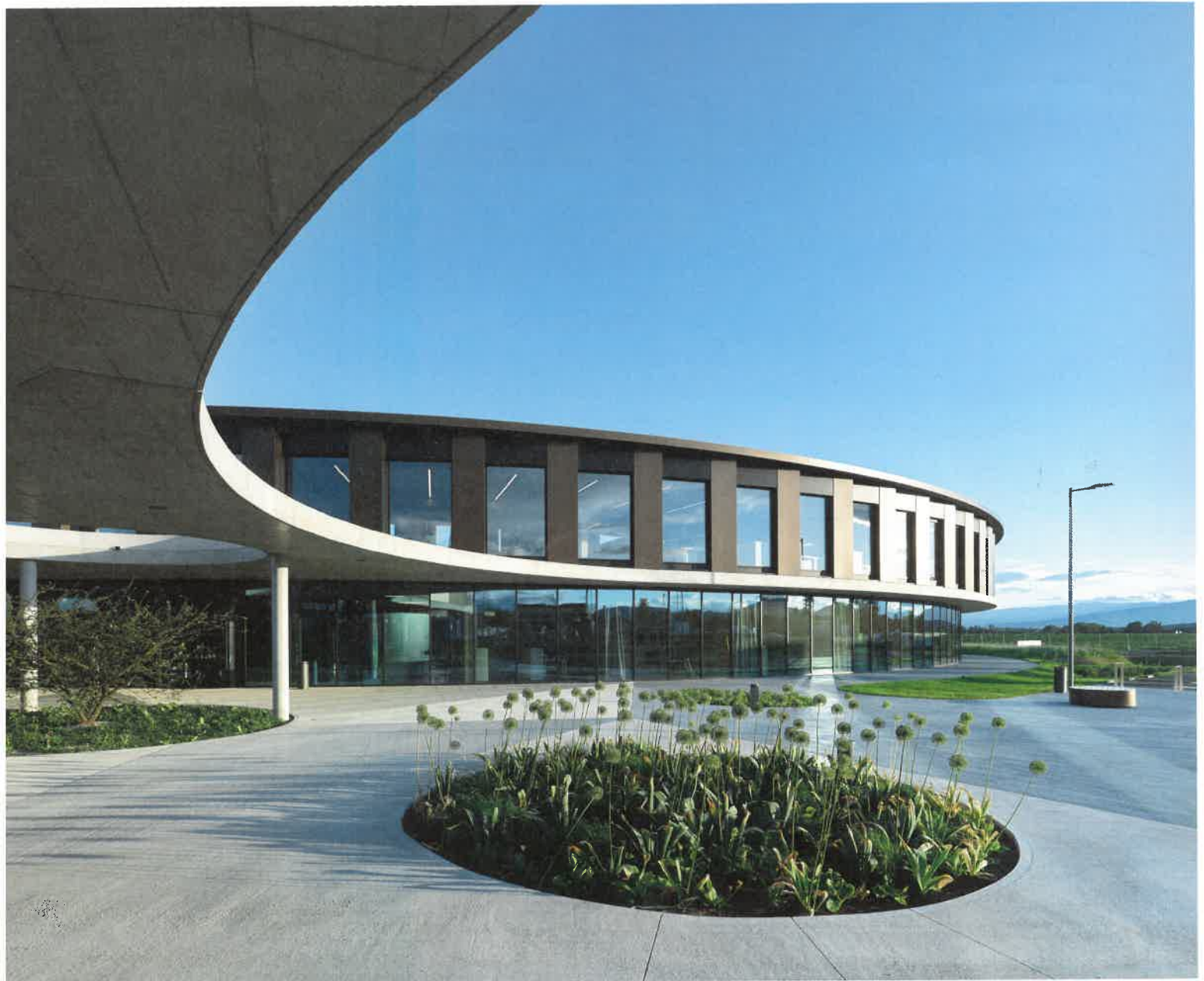
Der größte Ring der modularitg erweiterbaren Anlage birgt die Büros, der oben umlaufende Fensterkranz ist in bronzeeoxiertem Aluminium gefasst.
