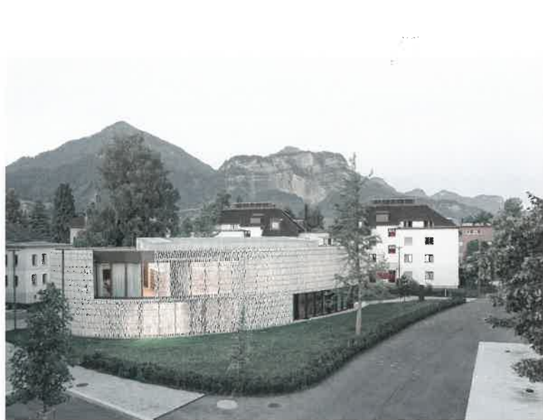
Neubau der Bibliothek ebnet sich exakt auf dem auf eines Trampelpfades ch die Parkanlage.
