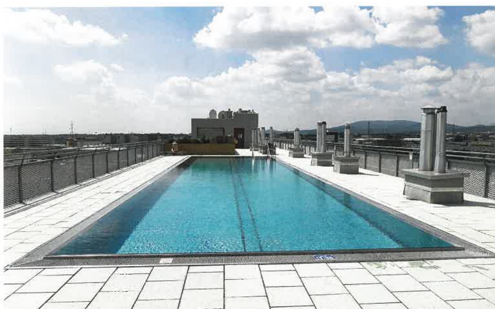
Nur für hauseigene Mieter – das Schwimmbad am Dach, mittlerweile ein Markenzeichen von Wohnbauten der Wien-Süd, sorgt für Abkühlung und einen sensationellen Ausblick.
