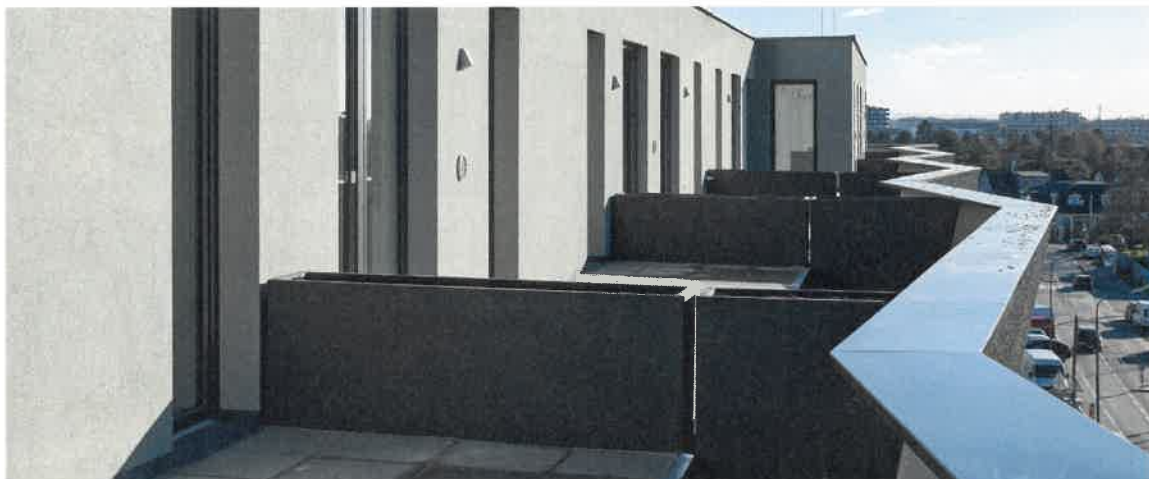
Vertikale und horizontale Wellenbewegungen an der Fassade.
