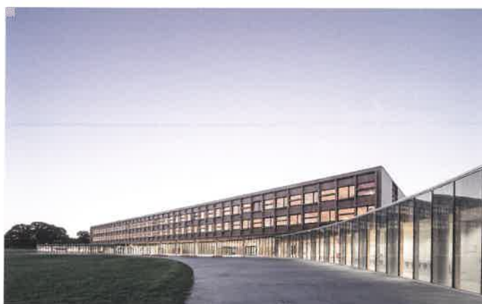
▲ Les deux niveaux de salles de classe font figure de long parallélépipède de bois, posé sur un socle translucide qui s'incurve pour embrasser le paysage et la cour.
