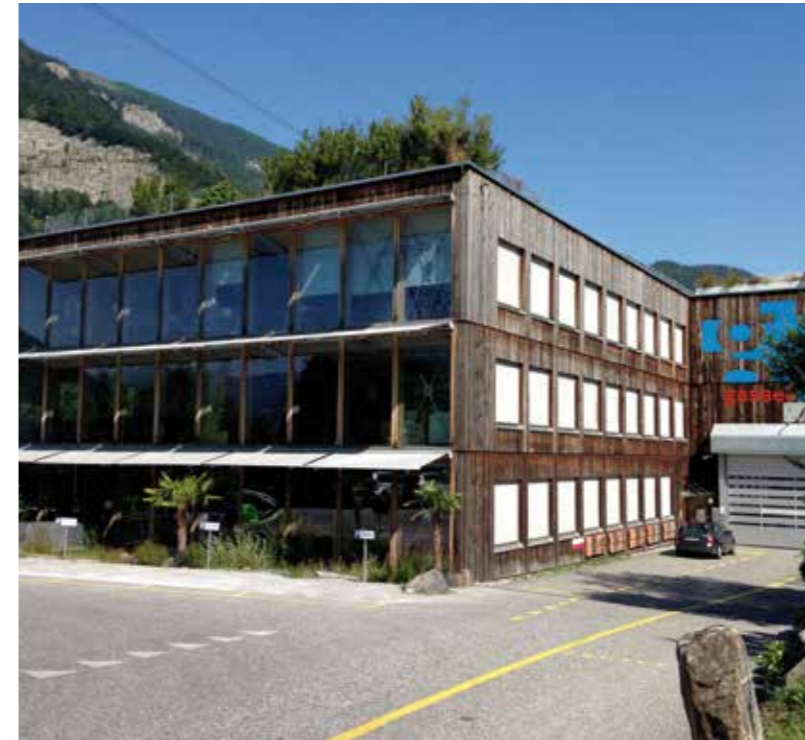
Festverglaste Südfassade mit aussen liegendem Sonnenschutz.
