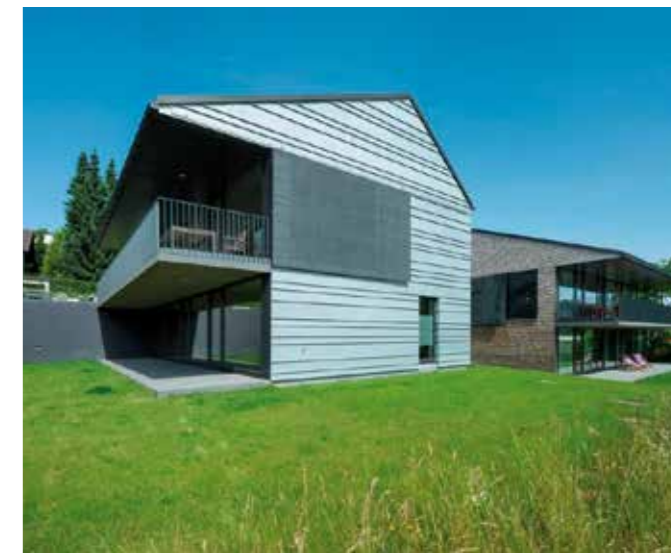
Auf der Ost- und der Westseite sind grosse Schiebelemente mit Streckmetall als bewegliche Sichtschutzelemente angebracht.
