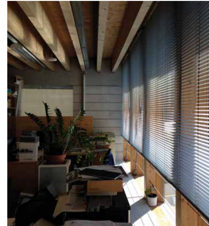
Die sichtbaren Kalksandsteinwände und Brettstichholzträger an der Decke werden ebenfalls als Speichermasse genutzt.
