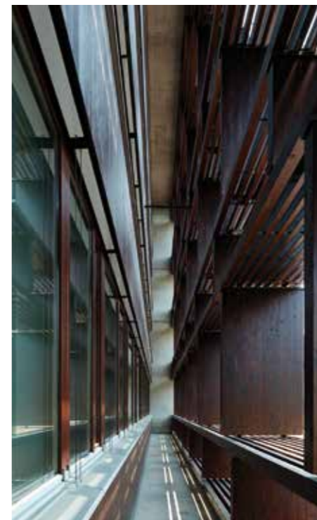
Abstand und Tiefe des Holzrasters sind so geplant, dass die Sonne in der warmen Jahreszeit nicht direkt durch die Glasflächen scheinen kann.
