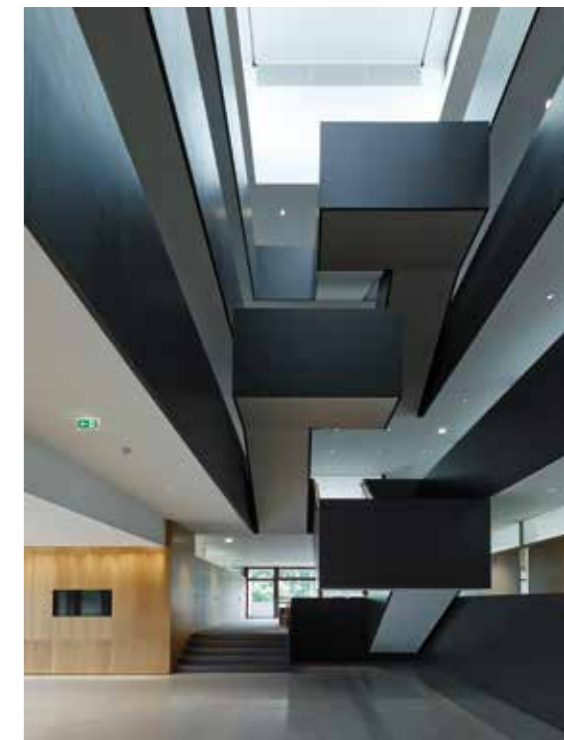
An den Erschliessungszonen kann warme Luft bis in die Laternen über dem Gebäude aufsteigen.
