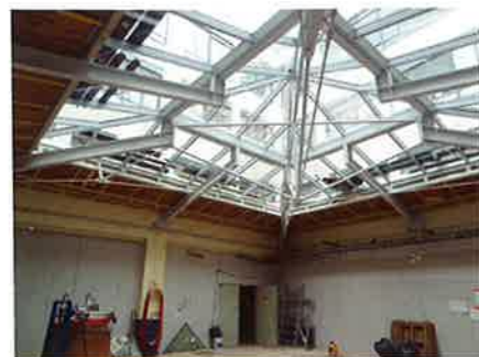
Montage de la verrière.
