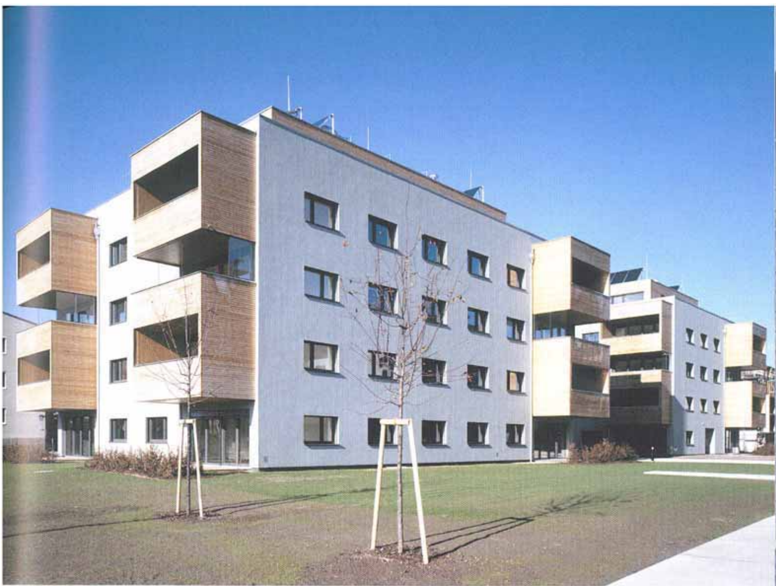
Passivhaus-Standard: Kleine Öffnungen und 32 cm Wärmedämmung Passive house standard: compact shape and 32 cm thermal insulation
