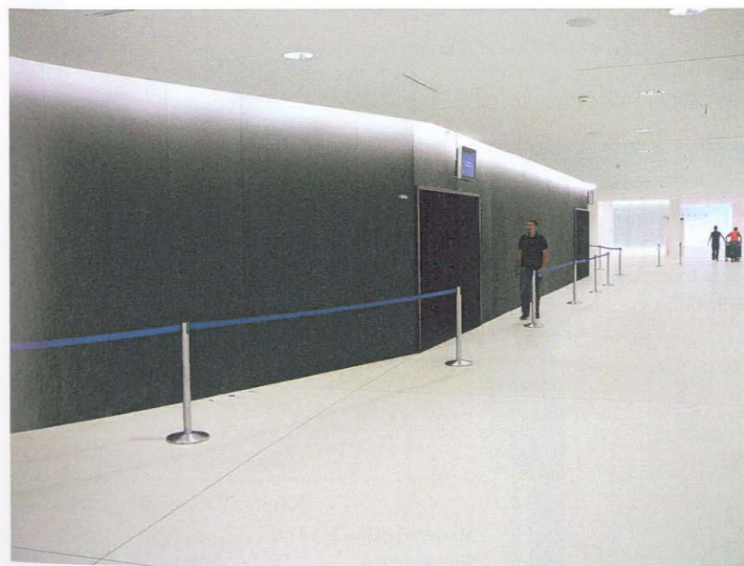
Auch innen wurden die Wände mit concrete skin gebaut; die Oberfläche liquid black schafft eine elegante Ausstrahlung.
