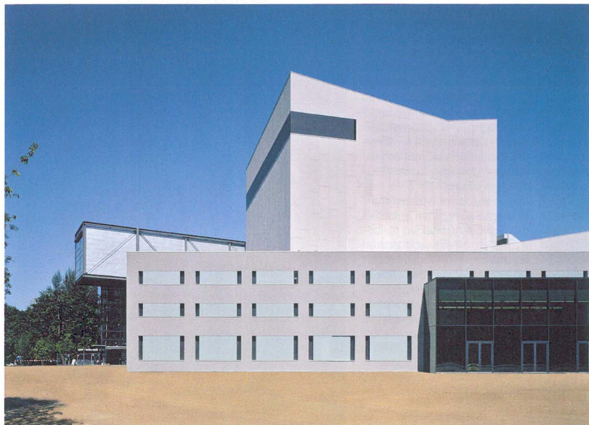
Das Festspielhaus Bregenz präsentiert sich nach seinem Umbau als kompositorische Einheit mehrerer Baukörper.
