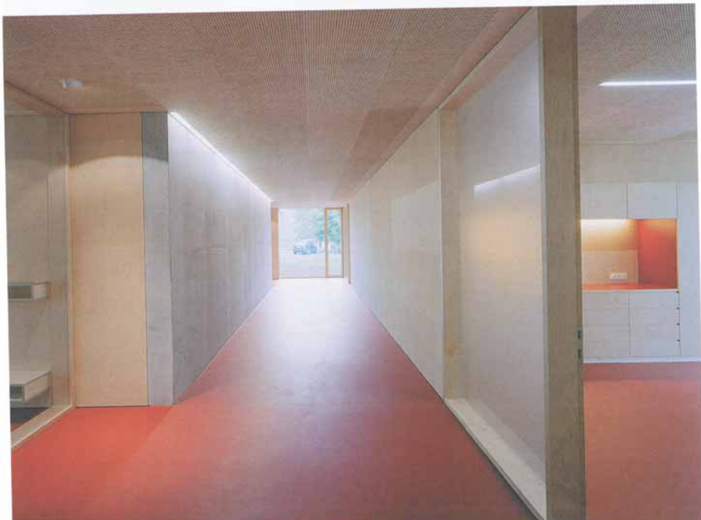
Der Proberaum wurde akustisch vom Kindergarten abgekoppelt. Dieser Gebäudeteil wurde in Stahlbeton gebaut.
