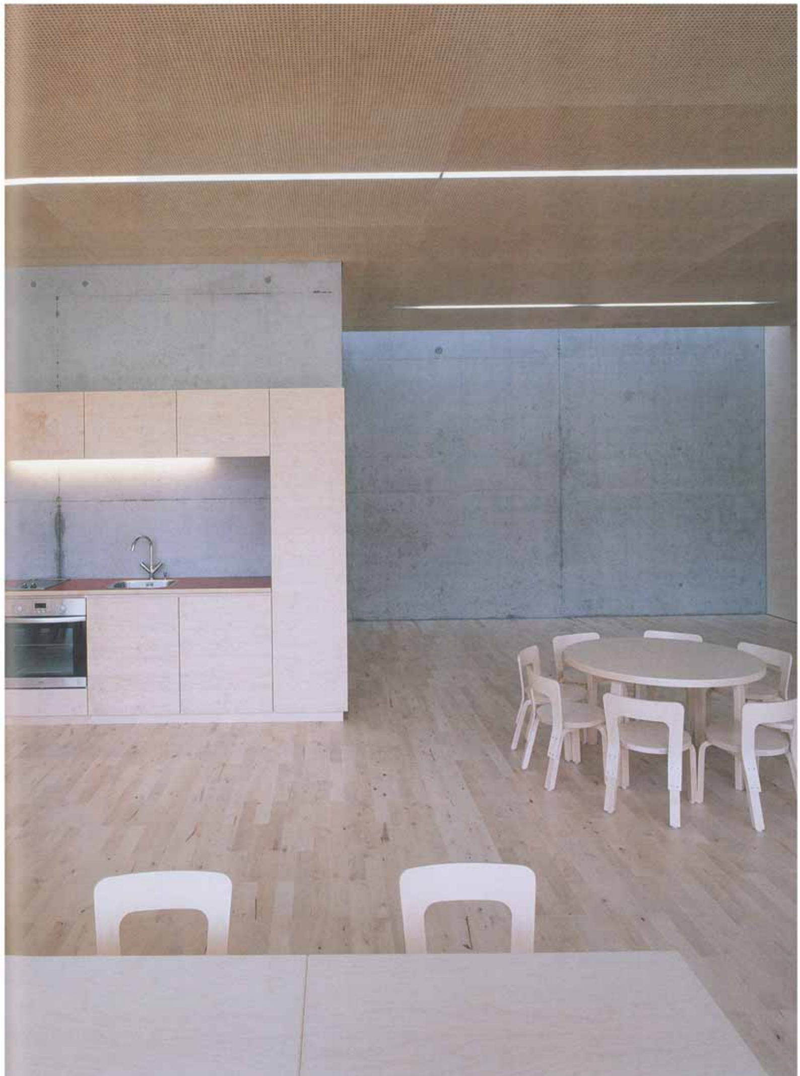
Wände und Böden im Kindergarten sind mit Birkensperrholz verkleidet. Sichtbeton bildet einen Kontrast dazu.
